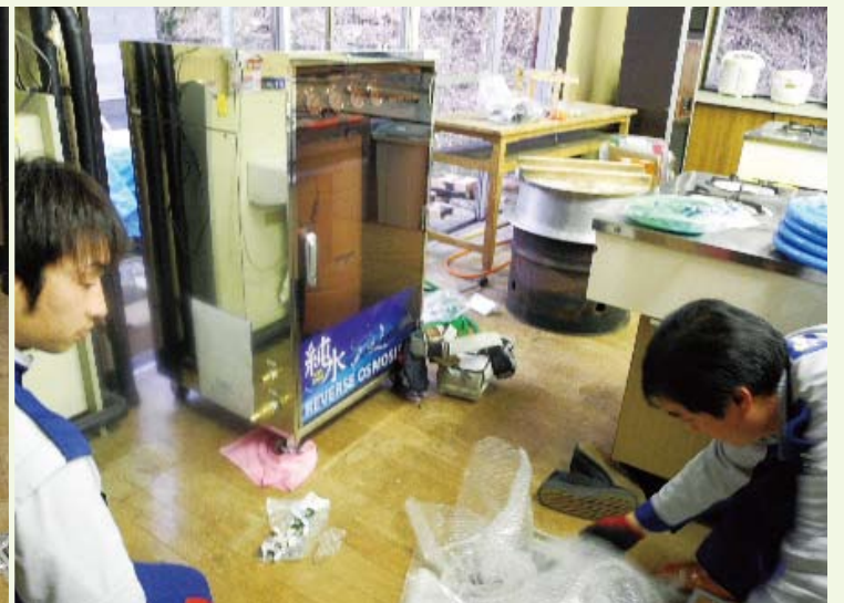
RO装置の設置を行った弊社仙台営業所の澤田君と大和君
