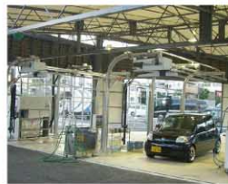
快洗Wing2台と快洗FIT-W1台の計3台を設置。
