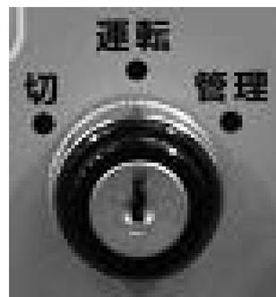
※ダウンモードにすると、凍結防止期間内の場合、エアブローによる管路内の水抜き処理を行います。エアブロー処理は外気温に関わらず行われ、1サイクル（約10分）継続します。中止したい場合は、管理モードにします。
